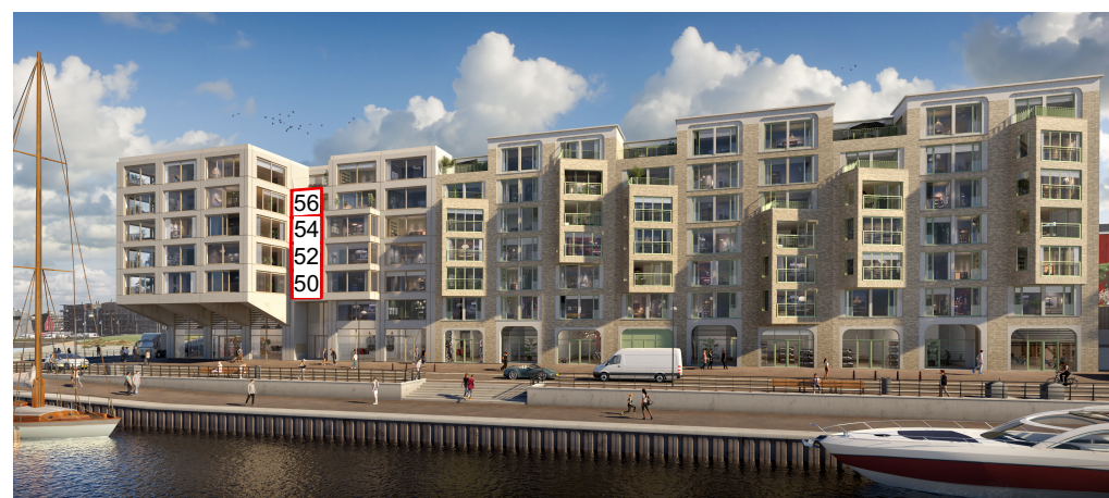
gevelaanzicht bouwdeel LEVS
