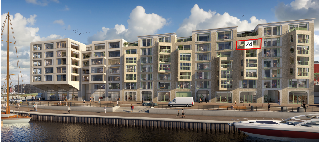
gevelaanzicht bouwdeel ZECC
