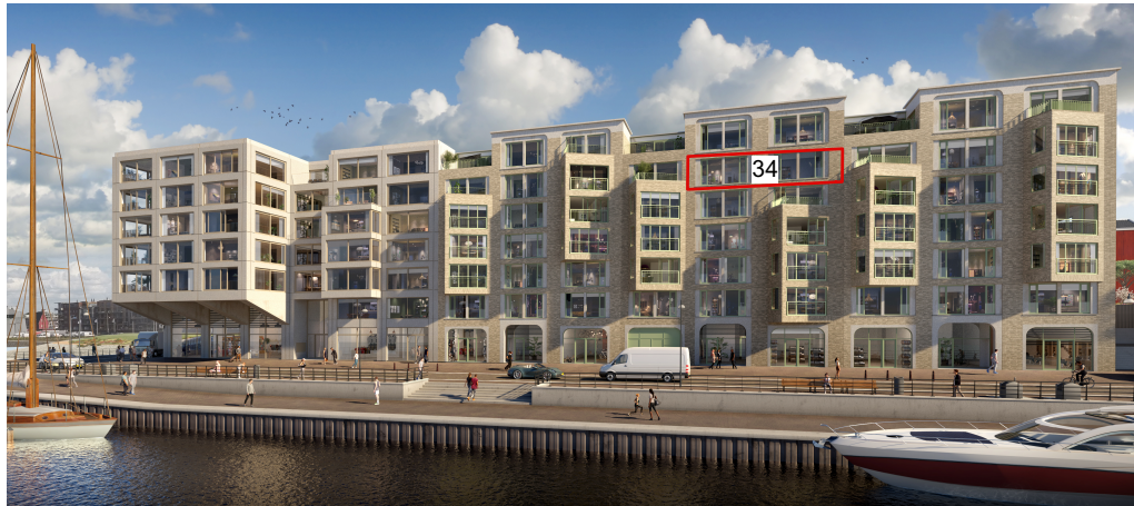
gevelaanzicht bouwdeel ZECC
