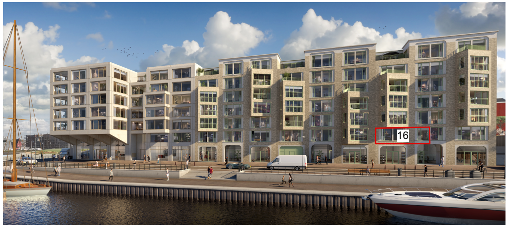
gevelaanzicht bouwdeel ZECC
