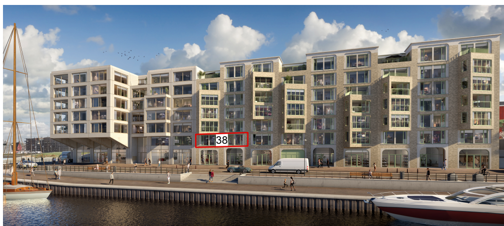
gevelaanzicht bouwdeel ZECC
