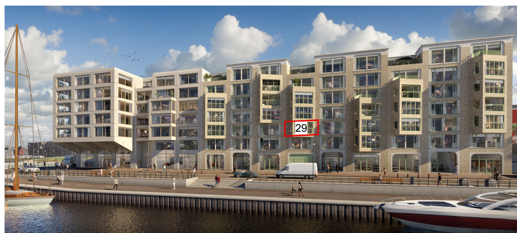
gevelaanzicht bouwdeel ZECC
