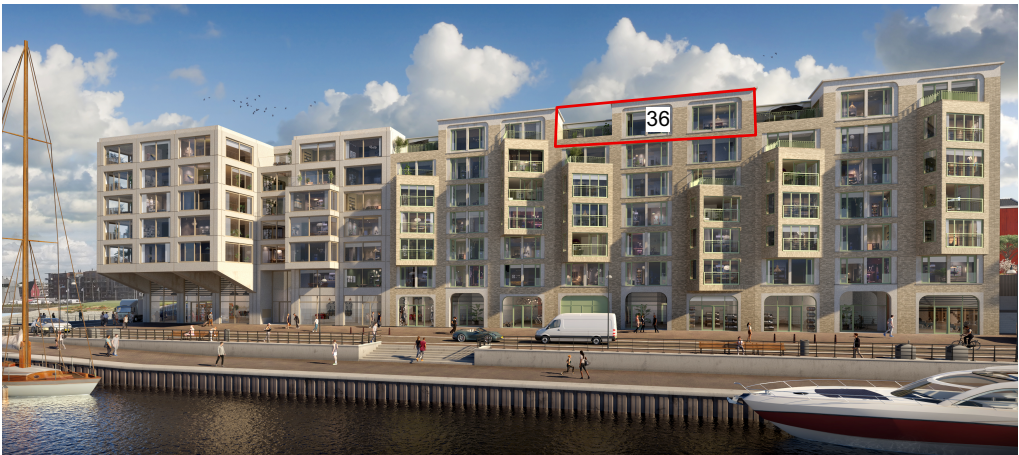
gevelaanzicht bouwdeel ZECC
